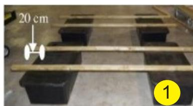
1 - Placer les flotteurs et les longerons en les laissant dépasser de 20cm de chaque côté.
